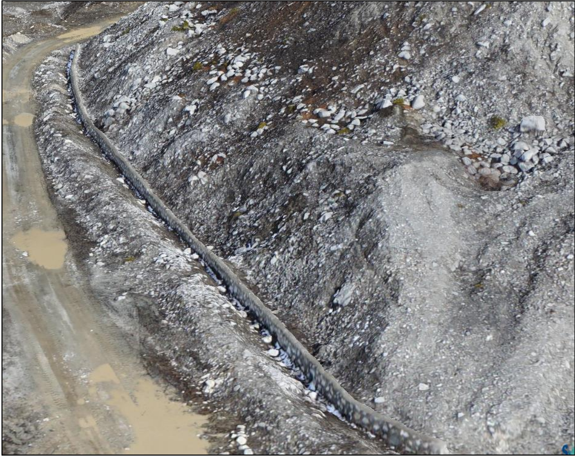
照片 4 2 号排土场挡土墙
