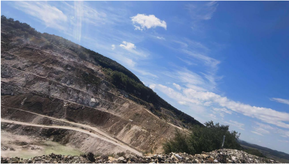
照片 1 I 采区边坡现状
