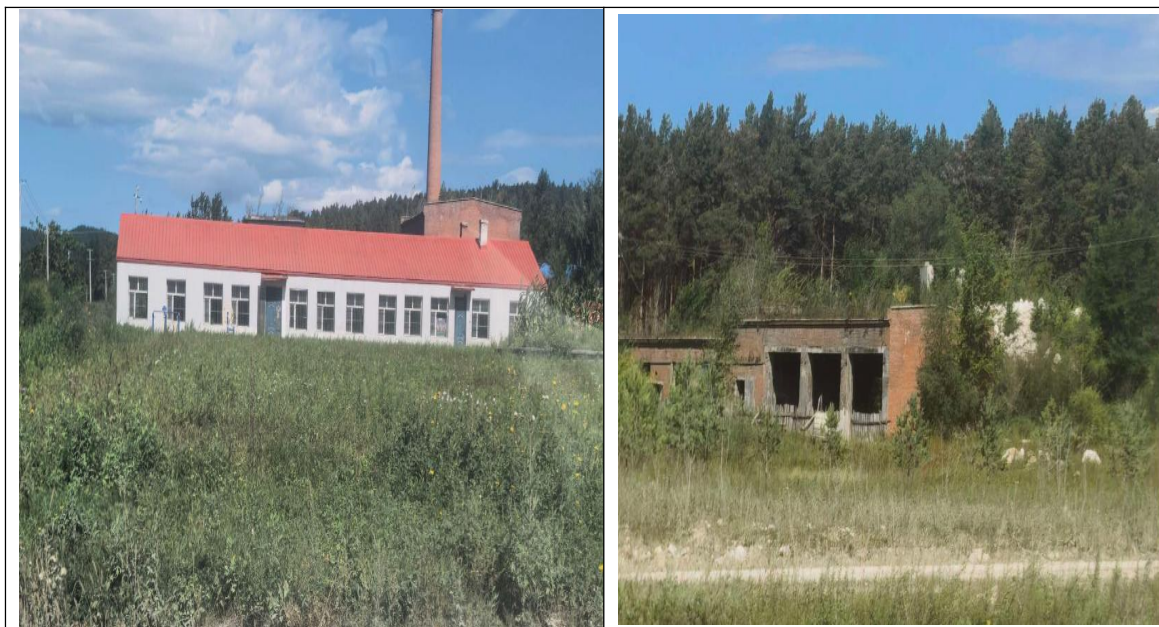
照片 部分房屋现状
