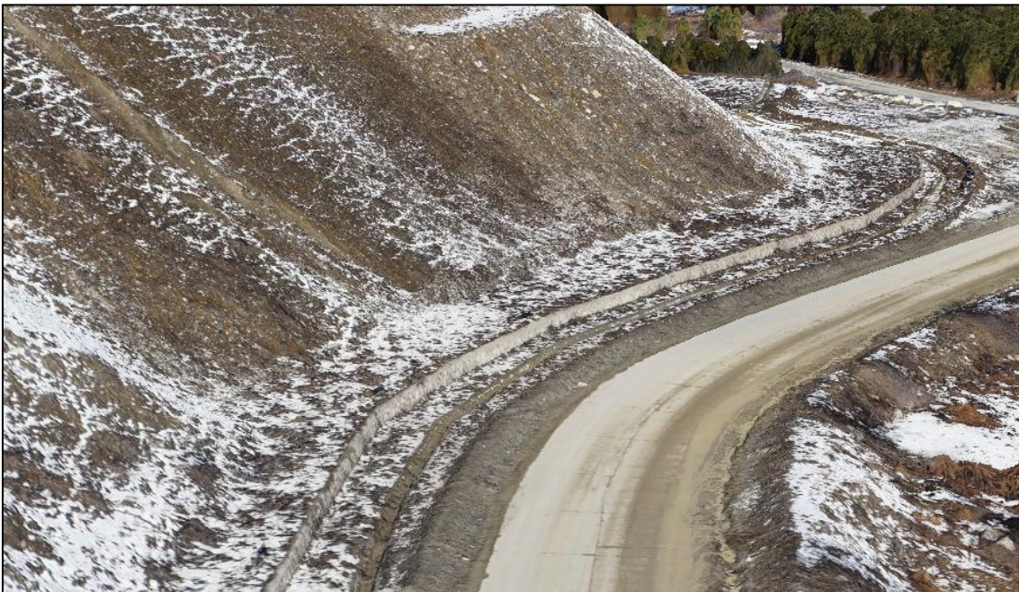
照片 2 1 号排土场挡土墙和排水沟
