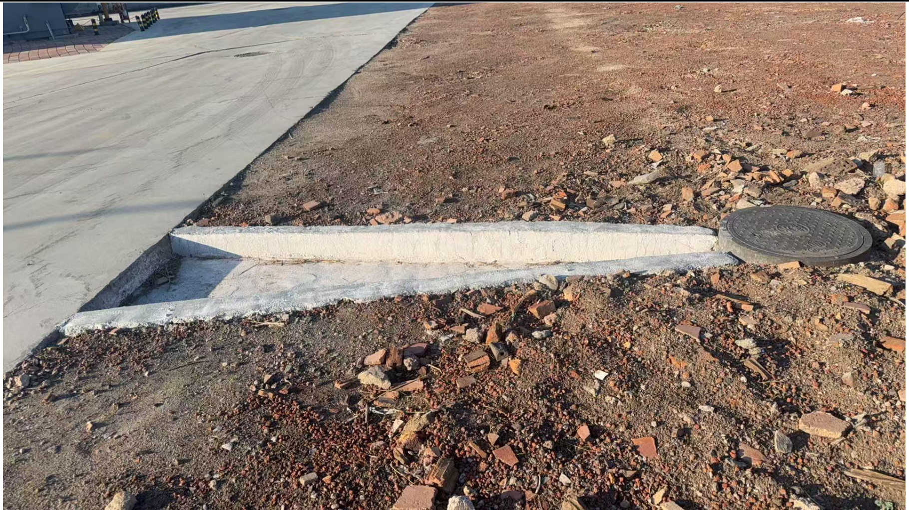
初期雨水收集池
