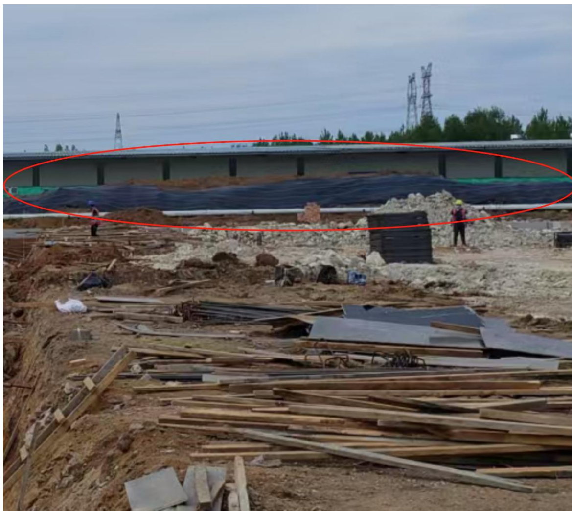
附件 14 临时措施影像资料（施工阶段）
