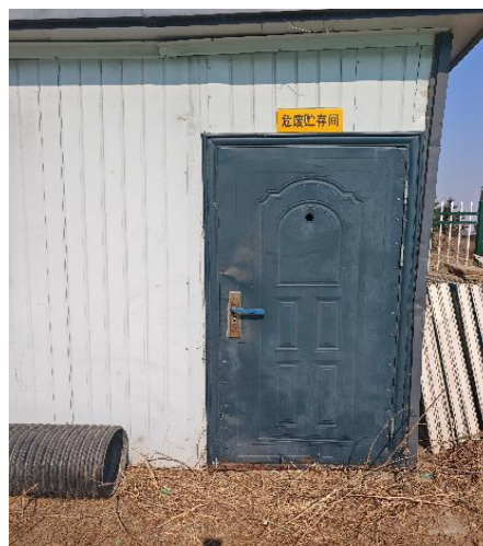
危险废物贮存点
