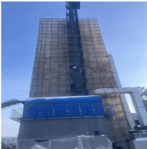
现有工程烘干塔
