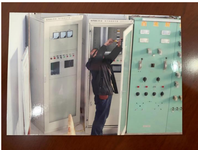
电器设备更换
