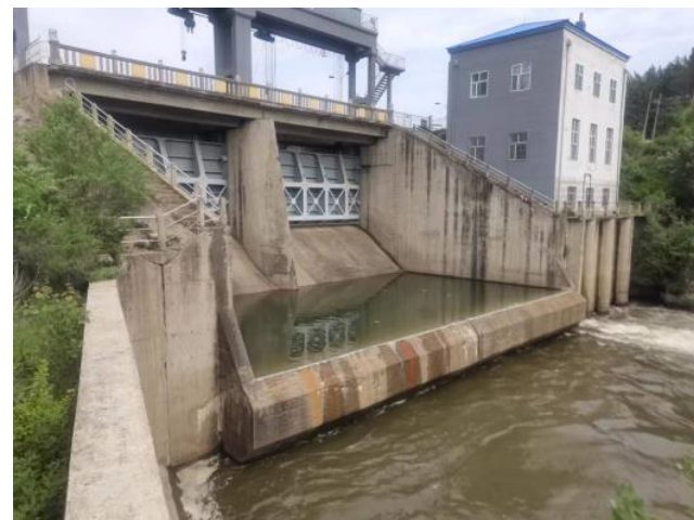
厂房及出口段（现状）
