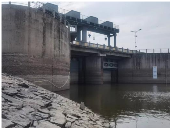
水库溢洪道及输水洞进水口（现状）
