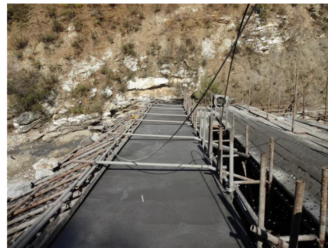
尾水渠拆除重建
