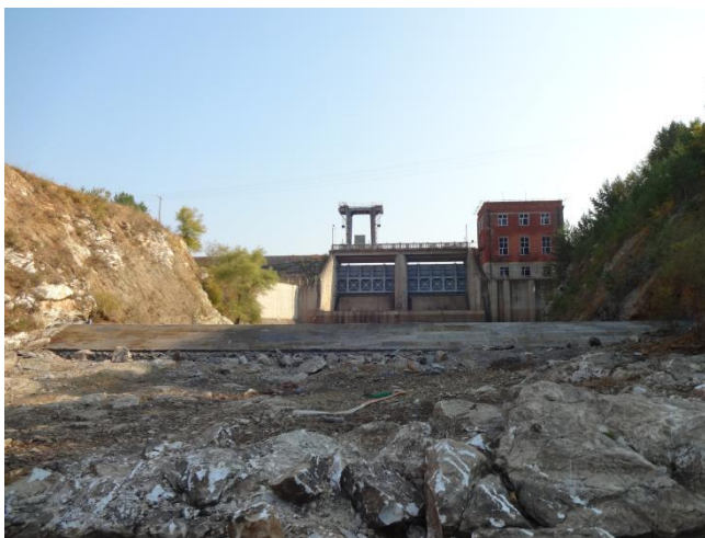
尾水渠拆除重建
