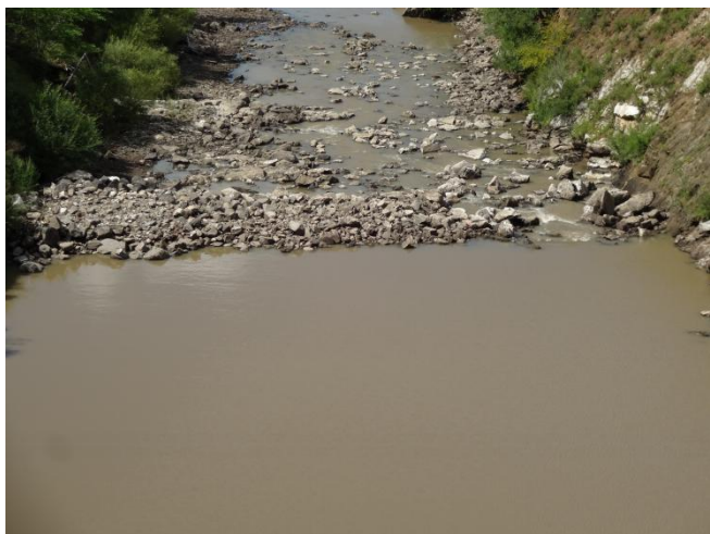
尾水渠拆除重建
