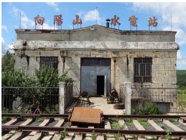
电站厂房改造前
