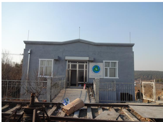
电站厂房改造后
